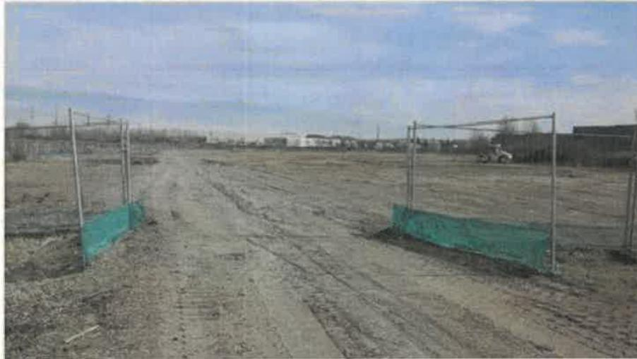
Figure 32 : Exemple de barrière amovible sur les accès chantier
