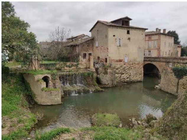
Le seuil du canal adossé au Moulin
