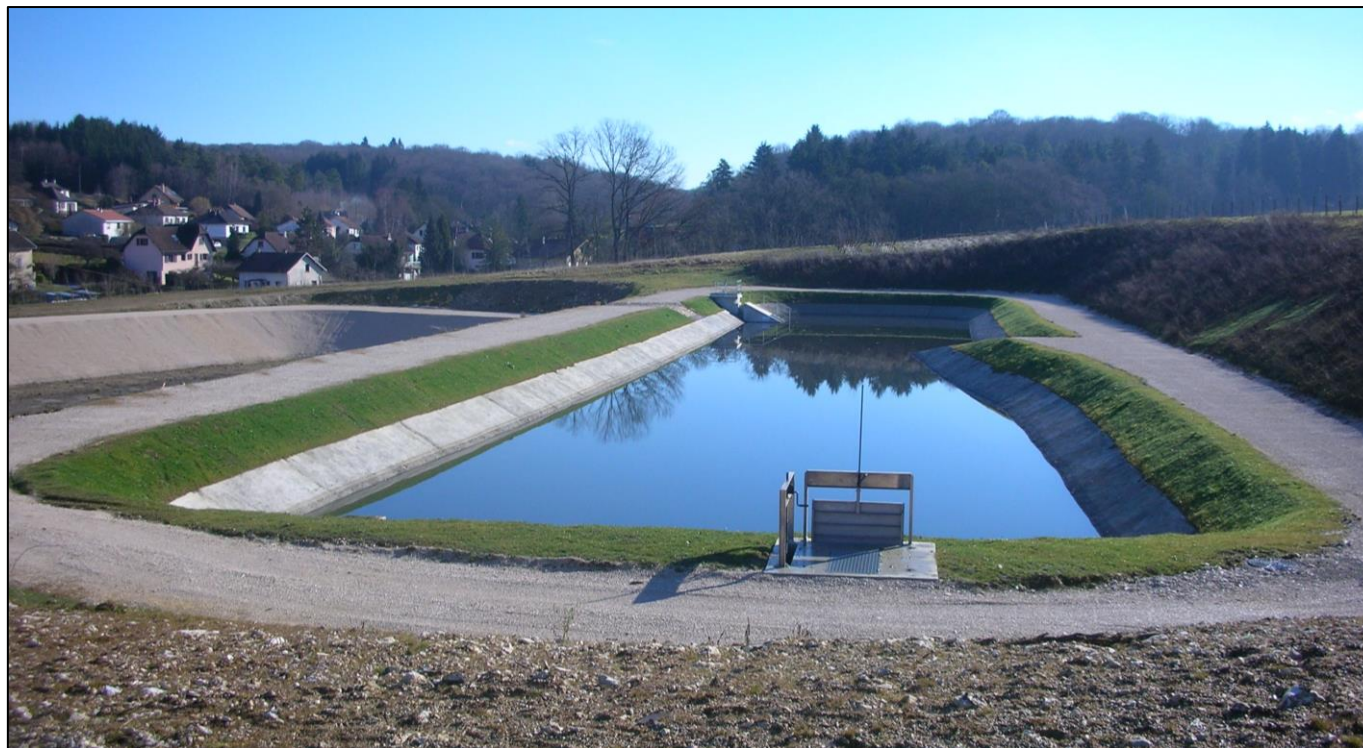
Exemple d’un bassin de traitement sur l’A36 – Source : setec
