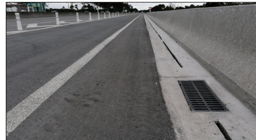
Exemple de dispositif longitudinal : caniveau à fente sur l'A660 – Source : setec
