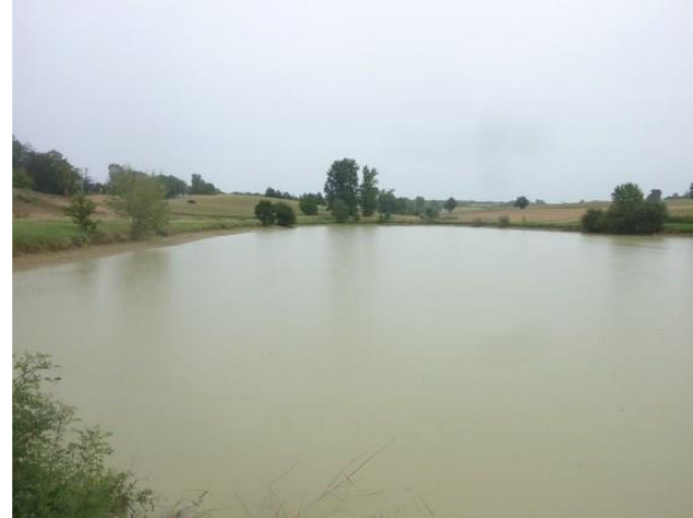
Retenue collinaire en série du ruisseau de la Passade
