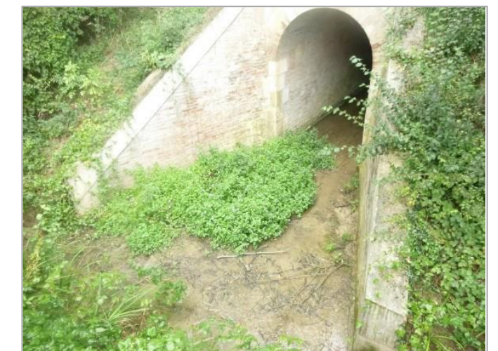
Confluence ruisseau de Guerrère – ruisseau de la Passade formant le ruisseau d’En Bon - En assec – Ouvrage de franchissement sous la RN124 actuelle
