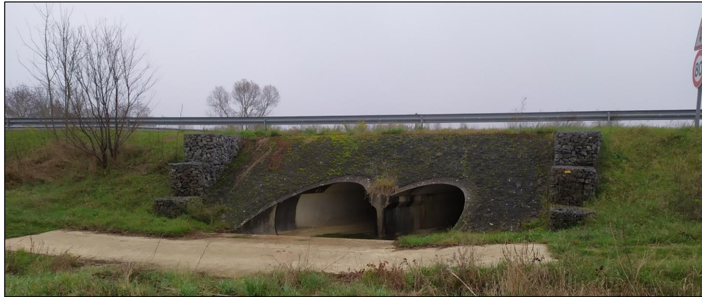
Ouvrage de décharge sous la RN124 – Source : Setec
