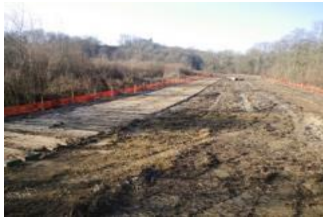
Figure 20 : Plat-bords en zone humide (bois à droite en bas et géotextile + géogrille en haut)
