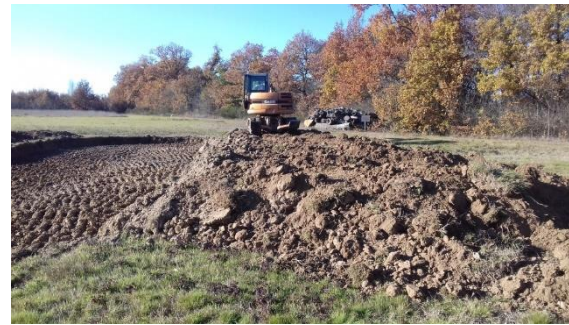
Décapage site récepteur
