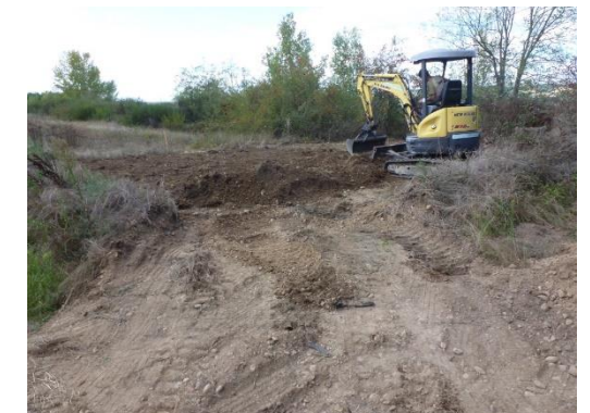
Dépôt de la terre sur le site récepteur
