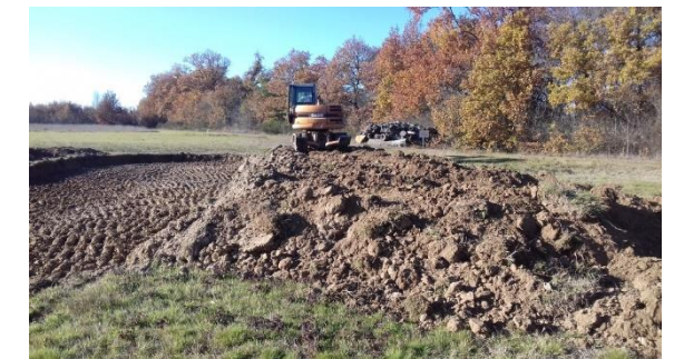
Décapage site récepteur
