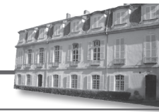
Sous-préfecture de Condom
