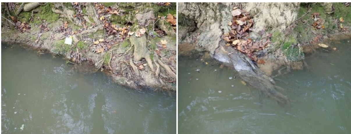
Figure 186 : Exemple de plafonds de sous-berges immergés en rive gauche
